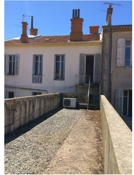
Terrasses du 3 ème étage BAT C et B
